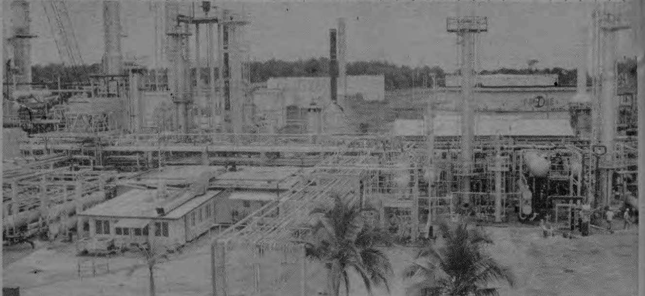
Después de estar paralizada durante cuatro meses, a raíz de los daños que sufrió con el terremoto y el incendio, a finales de agosto volverá a operar la refinería de Moín.
